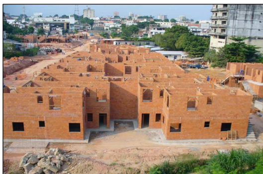
Figura 5: Igarapé de Manaus – início das obras Fonte: UGPI, 2007.
