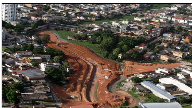
Figura 6: Igarapé do Bittencourt – início das obras Fonte: UGPI, 2007.
