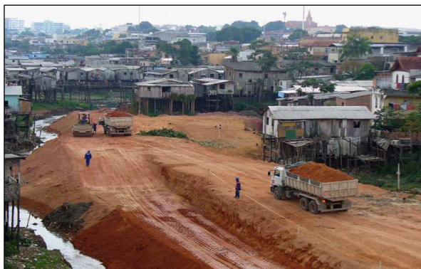
Figura 7: Igarapé do Mestre Chico – início das obras Fonte: UGPI, 2007.
