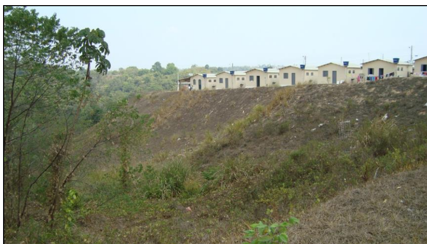
Figura 3- Taludes com forte declividade na área do conj.Habitacional Cidadão IX.
