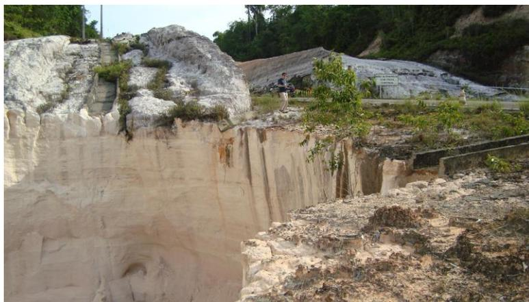
**Fig. 4** – Ocorrência de canaletas que escoam da pista para a voçoroca a água da chuva. BR 174 Km 52,1. Foto de Janara dos S. Tavares em 23/10/2009.
