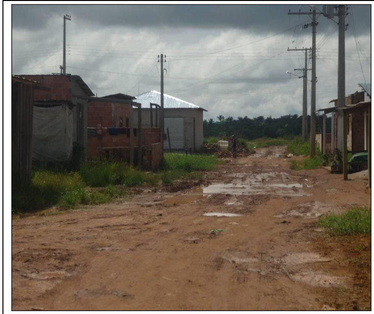
Figura 9 – Rua sem pavimento asfáltico na ocupação Nova Veneza Foto: Rosinete Cruz. Data: 18/01/2010
