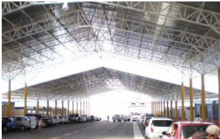
Figura 3 – Nova estrutura do Porto da Ceesa ( Abril 2010) Fonte: Própria
