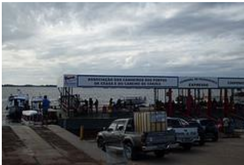
Figura 5– Novos atracadouros do Porto da Ceasa ( junho 2010) Fonte: Própria
