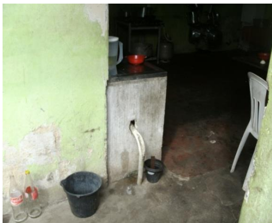
Fig.17 – Residência nº 4. Jun/2012
