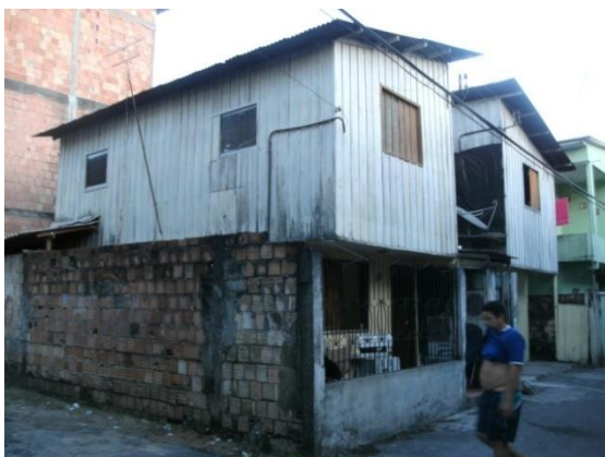
Fig. 23 – Residência Nº 6. Jun/2012 Fonte: Maria Eveli
