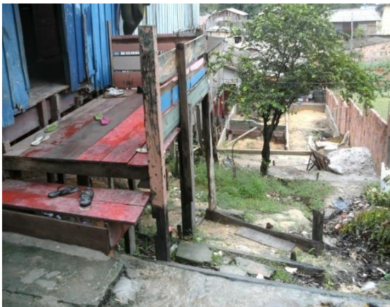
Fig. 21 – Residência nº 5. Jun/2012 Fonte: Maria Eveli
