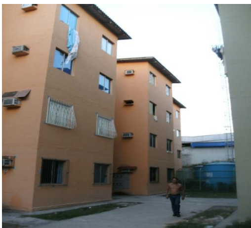
Fig. 25 – Residência nº 08. Jun/2012
