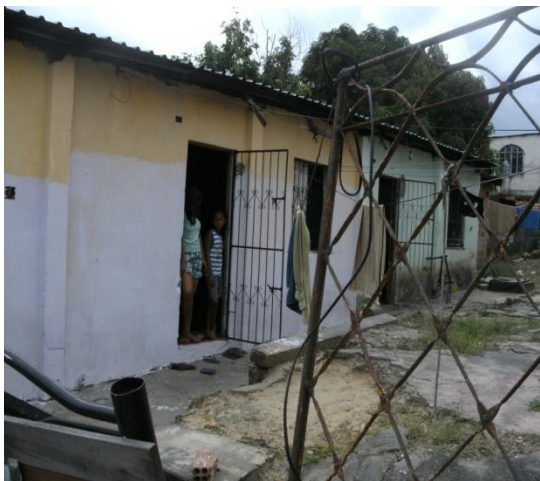
Fig.27 - Residência nº 9. Junho/2012
