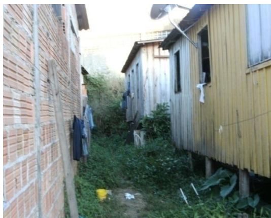
Fig. 15 – Residência nº 2. Jun/2012
