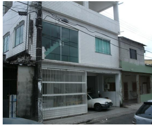
Fig. 20 – Residência nº 3. Jun/2012 Fonte: Maria Eveli
