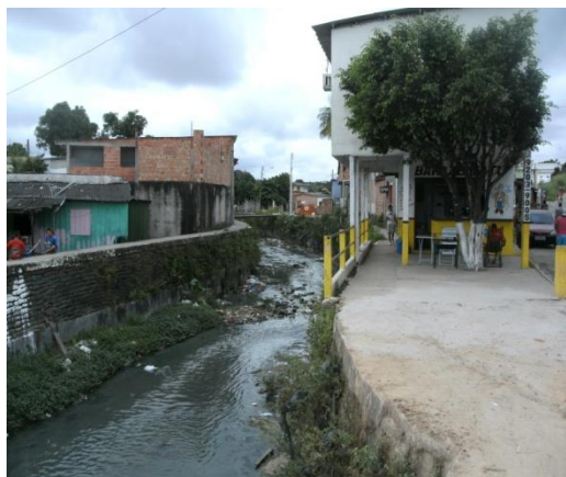
Fig. 18 – Residência nº 4. Jun/2012
