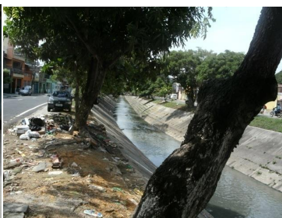
Fig. 12. Canal de igarapé/ Rua Cel. Salgado
