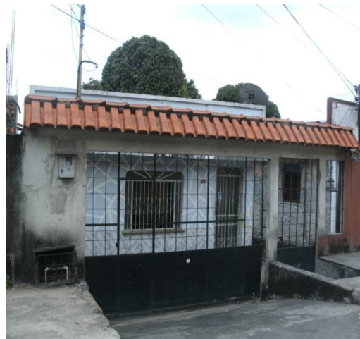
Fig.28 – Residência nº 14. Jun/2012
