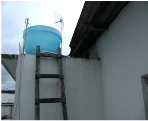
Fig. 19 – Residência nº 3. Jun/2012 Fonte: Maria Eveli
