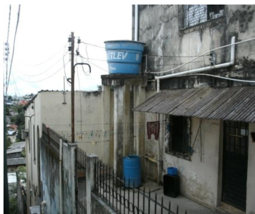
Fig. 16 – Residência nº 11. Jun/2012
