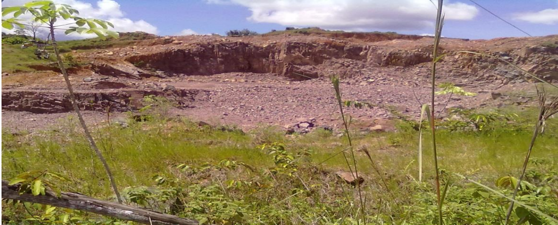
Figura 7: jazida abandonada- rodovia BR 174- Presidente Figueiredo-AM. Fonte: Alice Lucas
