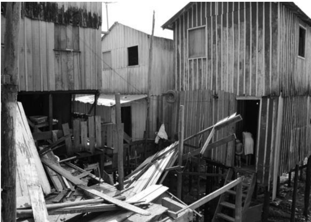
Figura 03, Casas de palafita demolidas. Foto: Juliana Sarmento, 2012.
