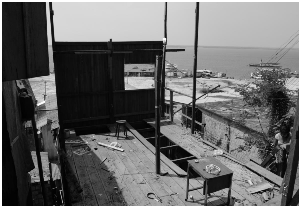
Figura 04, Casas de palafita demolidas. Foto: Juliana Sarmento, 2012.
