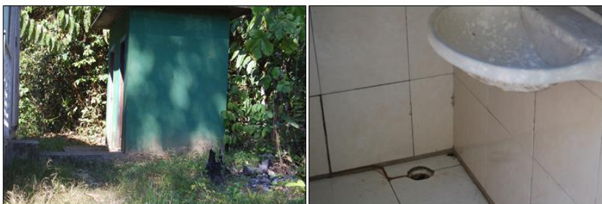
Banheiro da antiga Escola Helena Sofia, de Alvenaria.
