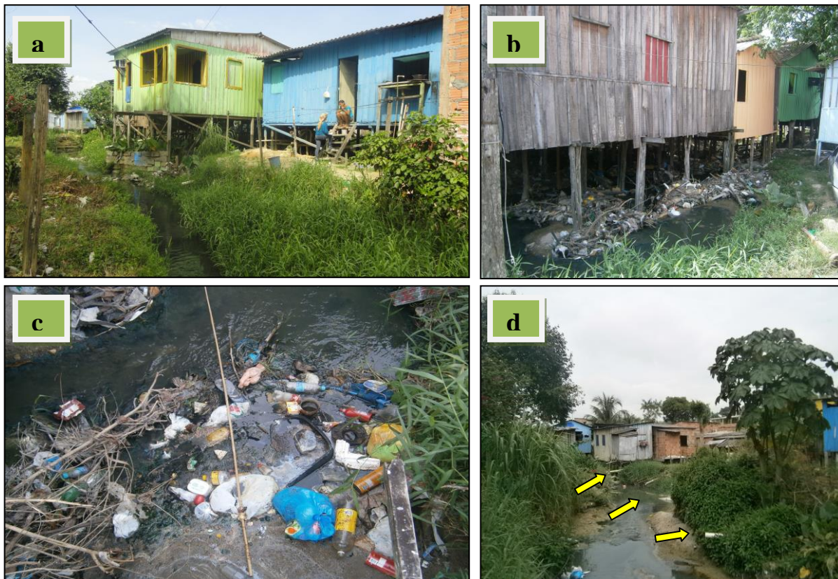
Fig. 05: a)Aplicação de questionários para a população;b e c) Lixo encontrado debaixo de casa e no igarapé;d)Pequenas tubulações onde se destinam os resíduos ao igarapé (seta amarela) Fonte: Lima (2013)
