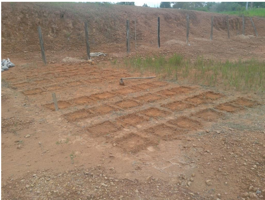
Figura 6. Área preparada para o recebimento dos tratamento T1 e T2.
