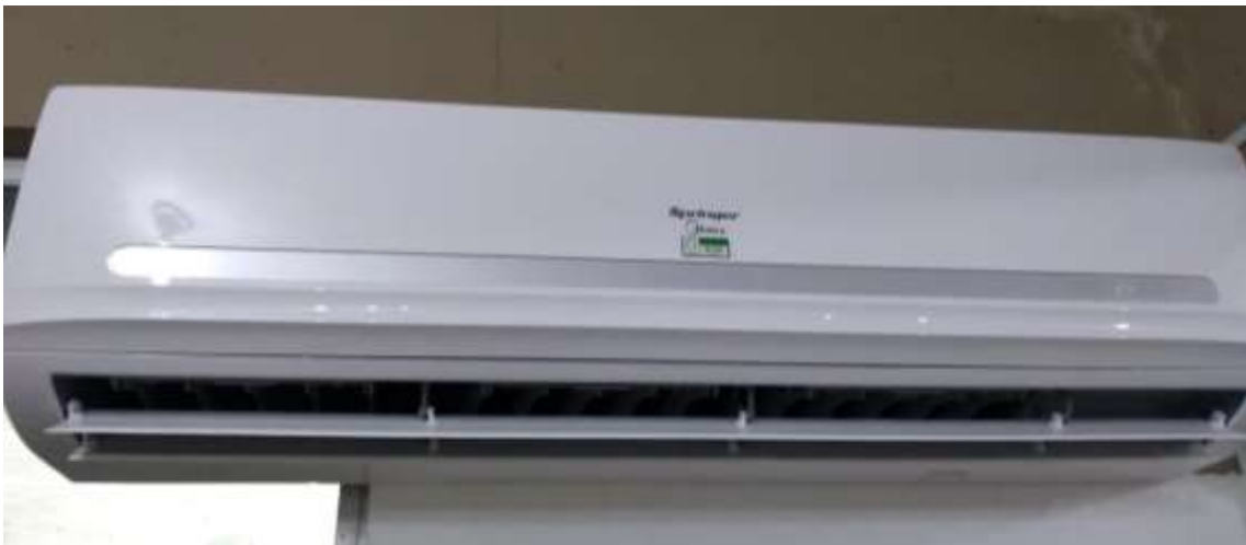
Figura 7. Modelo de Ar condicionado do tipo Split usado nas salas de aula do IEAA.
