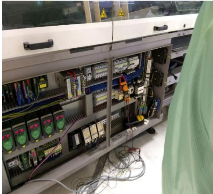
Figura 32 Instalação dos Sensores na Máquina de Solda
