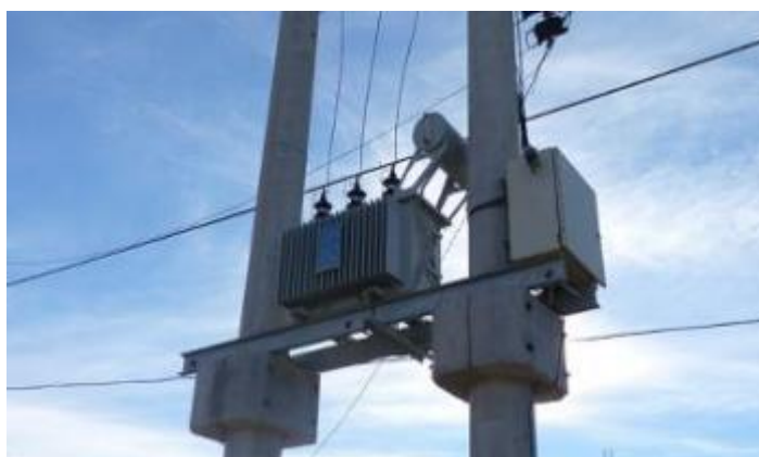
Figura 5 - Subestação simplificada (ou externa).
