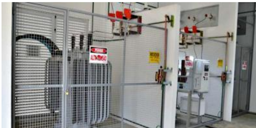
Figura 6 - Subestação abrigada.
