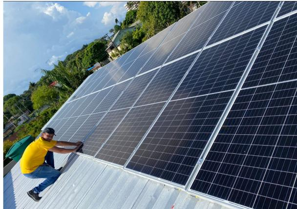
Figura 6.11: Instalação das Placas.
