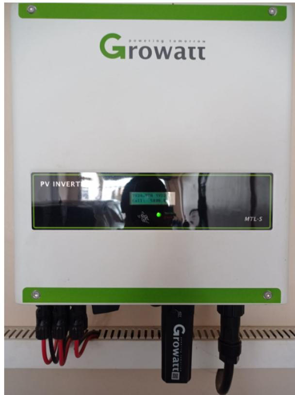
Figura 6.9: Inversor GroWatt de 8k.
