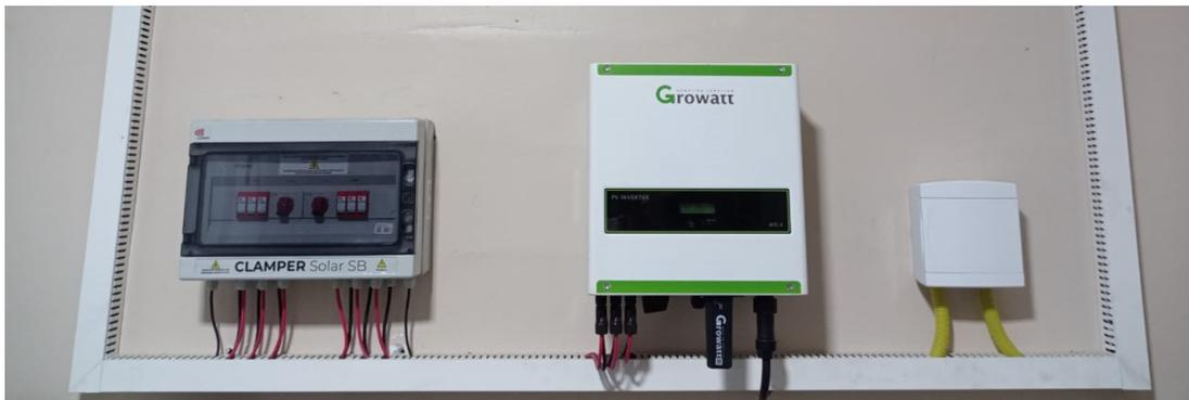
Figura 6.7: Instalação da StringBox DC, AC e Inversor.
