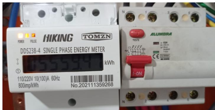
Figura 6.13: Medidor de energia da carga.
