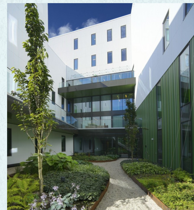
Fig. 32 - Hospital Psiquiátrico Kronstad Fonte: Pål Hoff, Helge Skodvin
