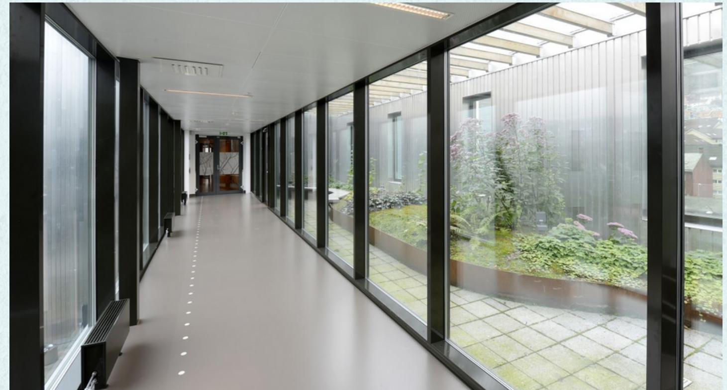
Fig. 27 - Hospital Psiquiátrico Kronstad Fonte: Pål Hoff, Helge Skodvin
