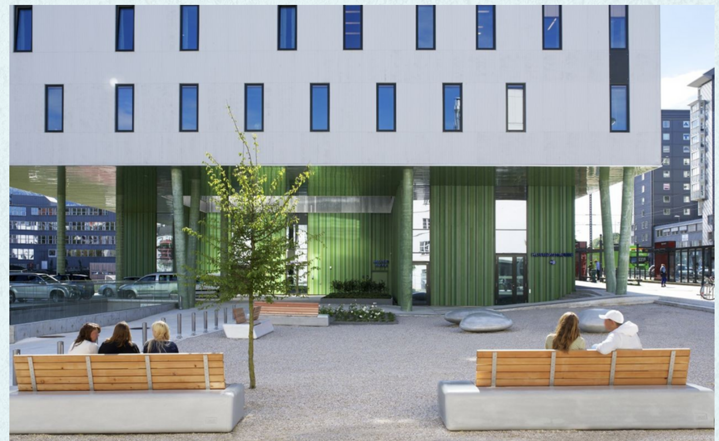
Fig. 28 - Hospital Psiquiátrico Kronstad Fonte: Pål Hoff, Helge Skodvin
