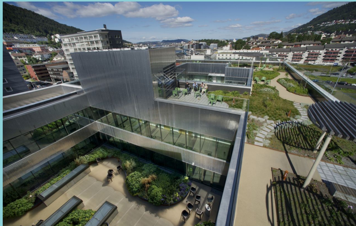
Fig. 25 - Hospital Psiquiátrico Kronstad Fonte: Pål Hoff, Helge Skodvin
