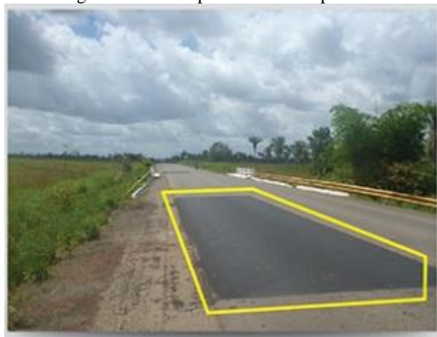
Figura 25 – Exemplo de remendo profundo
