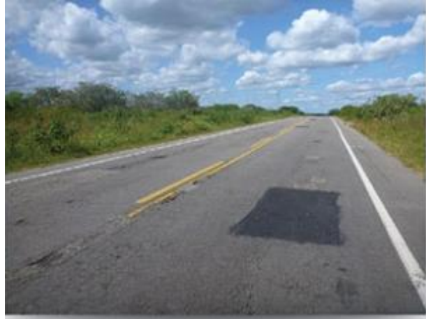
Figura 26 – Exemplo de remendo
