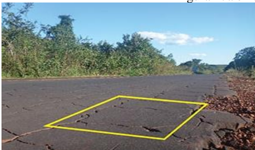
Figura 17a e 17b - Exemplo de trincas em bloco
