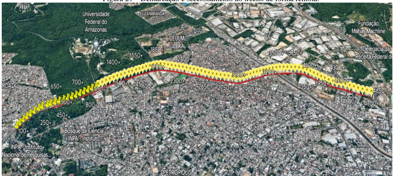
Figura 29 – Demarcação e seccionamento do trecho de forma remota.
