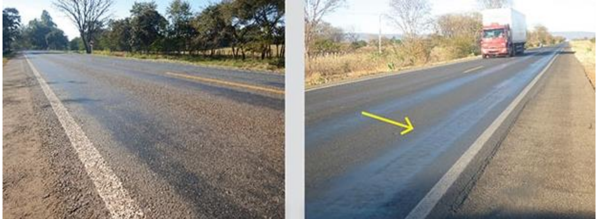
Figura 21 – Exemplo de exsudação no pavimento
