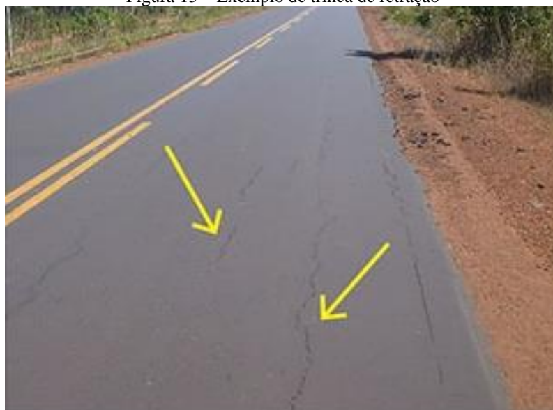
Figura 15 – Exemplo de trinca de retração
