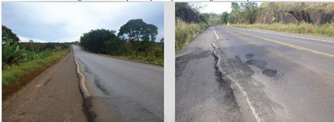
Figura 20 – Exemplos de presença de escorregamento na pista.
