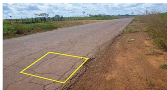
Figura 17a e 17b - Exemplo de trincas em bloco
