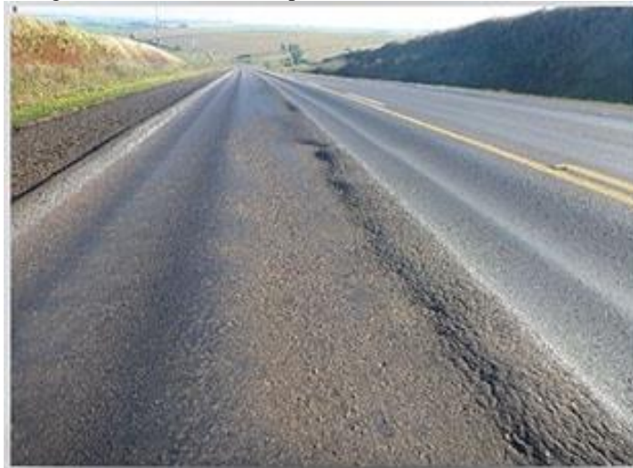
Figura 18 – Afundamento plástico nas trilhas de roda (ATP)
