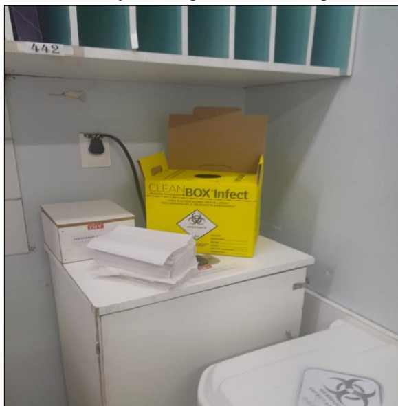
Figura 13 - Localização inadequada da caixa de perfurocortantes.
