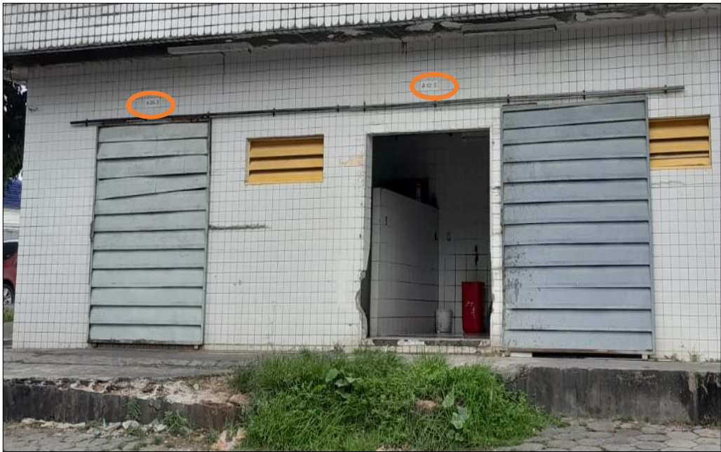
Figura 24. Placas de identificação dos resíduos presentes no abrigo externo.
