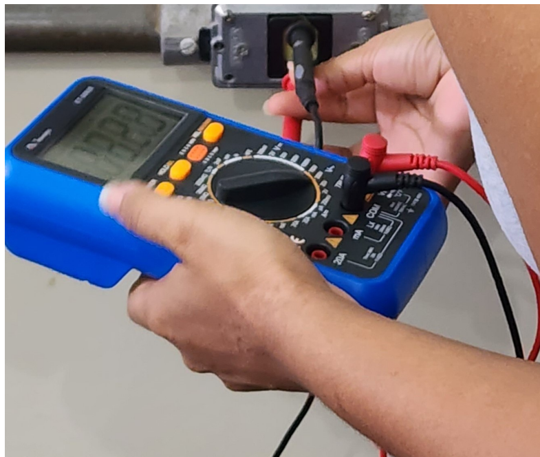
Figura 4.2 – Verificação da rede elétrica
