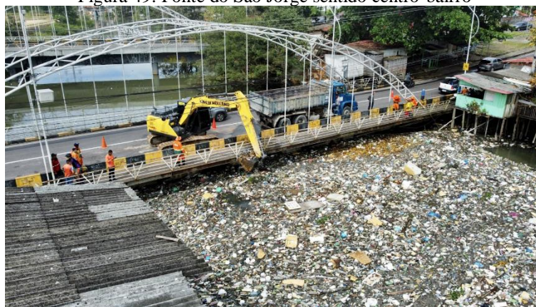
Figura 49: Ponte do São Jorge sentido centro-bairro
