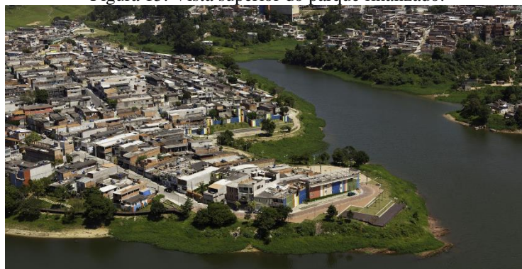
Figura 15: Vista superior do parque finalizado.
