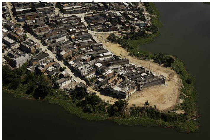
Figura 14: Vista superior da remoção das casas.
