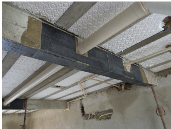
Figura 03 - Viga reforçada com fibra de carbono
