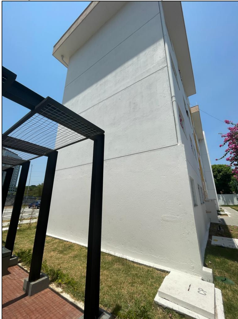
Figura 36 - Fachada do edifício onde será implementada o RVT.
