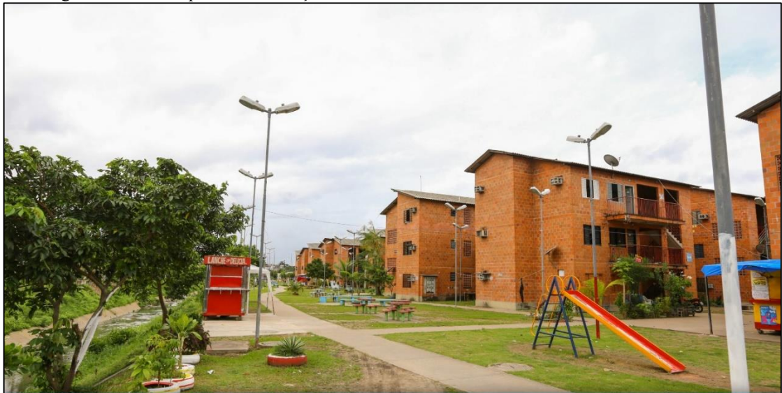
Figura 22 - Local após a revitalização urbanística, ambiental e habitacional do PROSAMIM.
