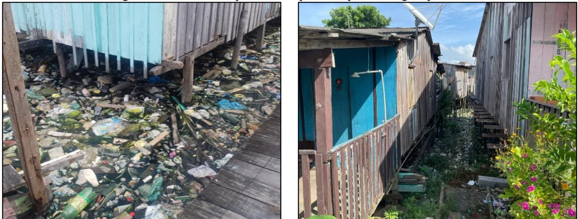
Figura 8 - Materiais suspensos transportados pela drenagem pluvial.
