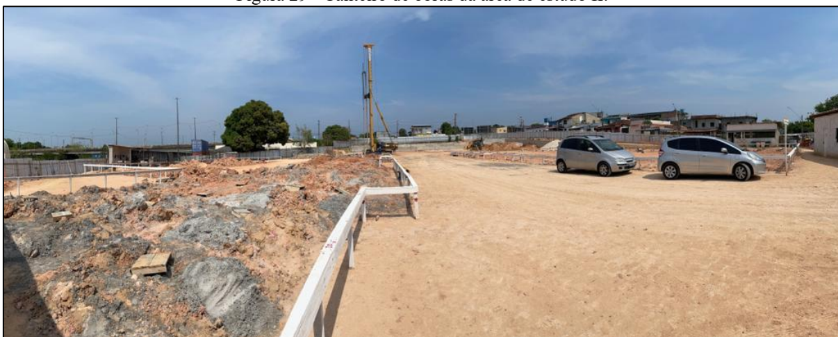
Figura 29 - Canteiro de obras da área de estudo II.
