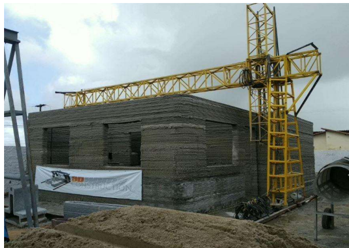
Figura 20 - Casa construída a partir da impressora criada pela InovaHouse3D e 3DHomeConstruction
