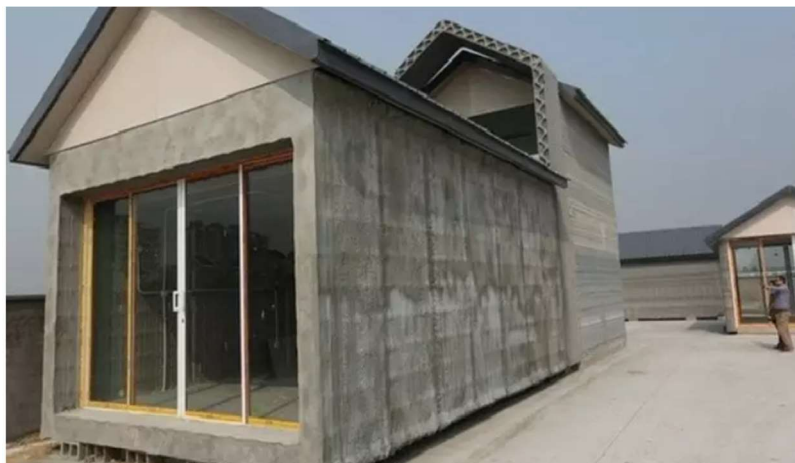
Figura 37 - Casa construída pela WinSun
