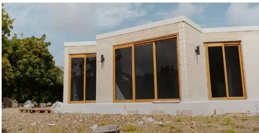
Figura 28 - Resultado externo da impressão da Robust Villa
