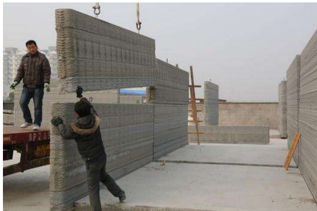
Figura 10 - Montagem das casas impressas pela WinSun
