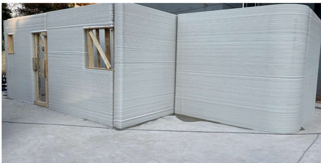
Figura 30 - UJ House: Primeira casa construída por impressão 3D da África do Sul
