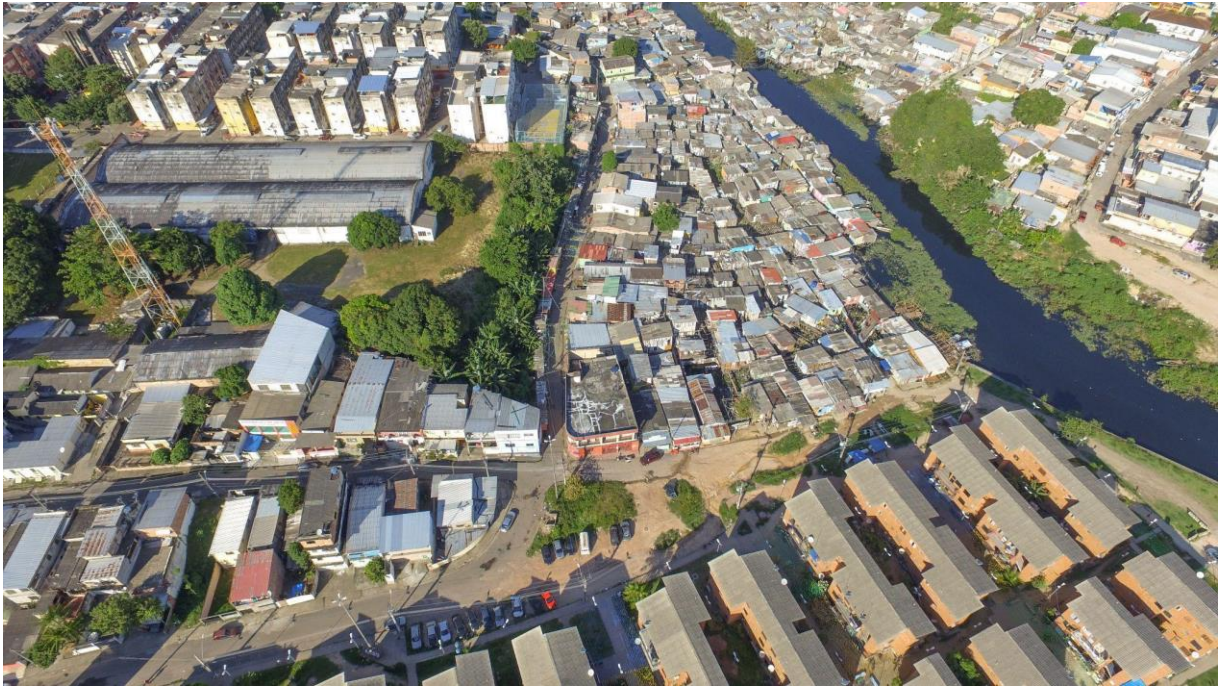
Figura 10 – Foto aérea da área a ser desapropriada.
