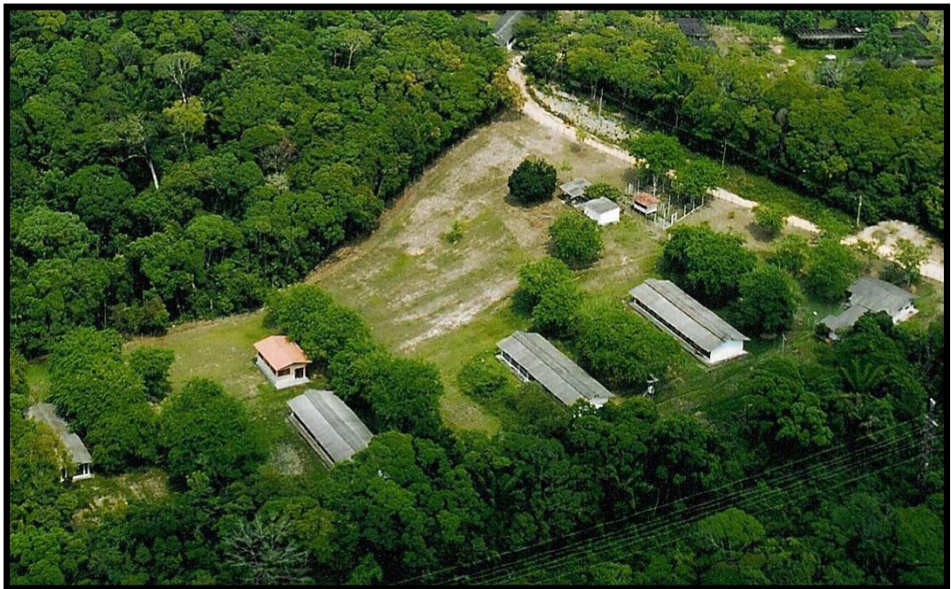
Figura 3. Vista aérea do Setor de Avicultura da Faculdade de Ciências Agrárias da Universidade Federal do Amazonas/ Mini-Campus, em Manaus.
