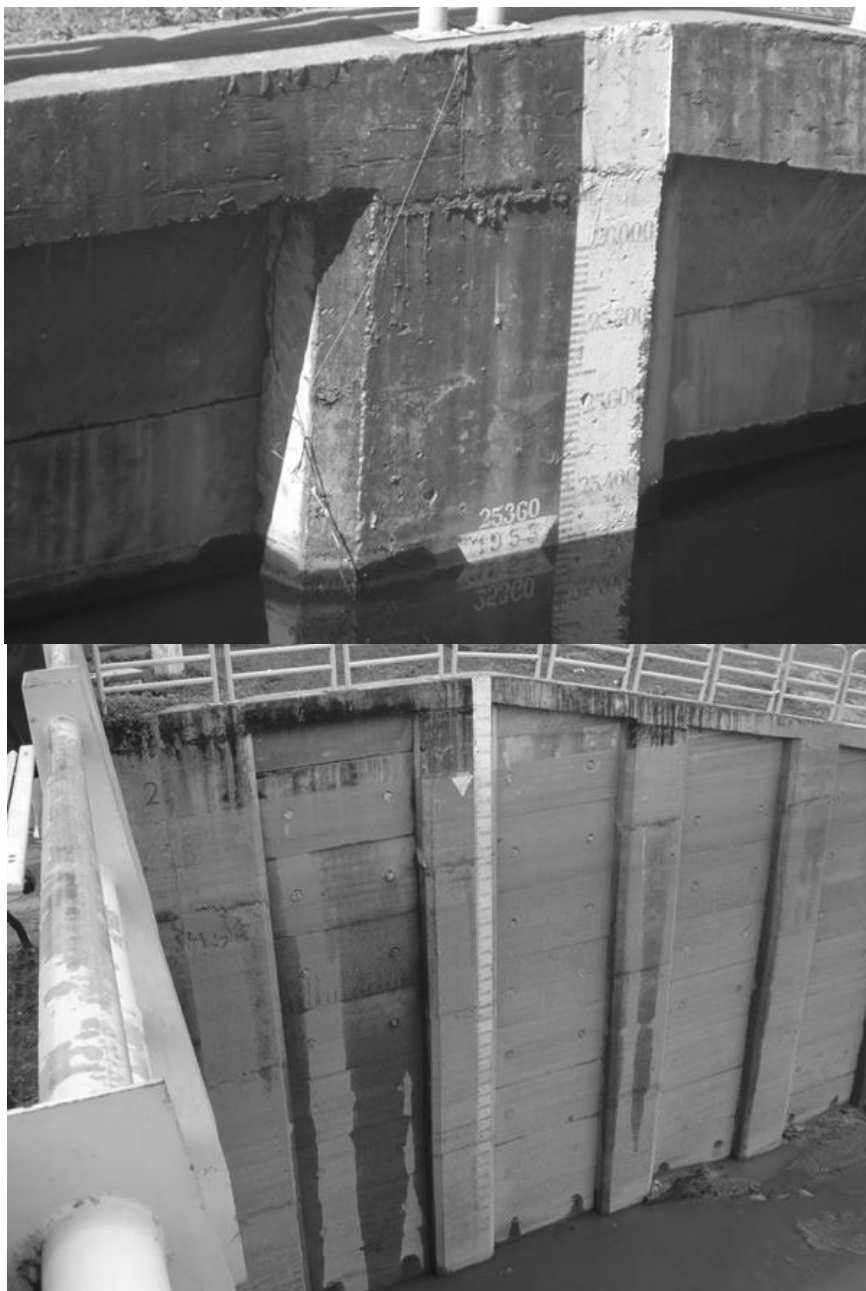
Figuras 6 e 7 – Escala pluviométrica no ápice da cheia e da seca de 2009.
