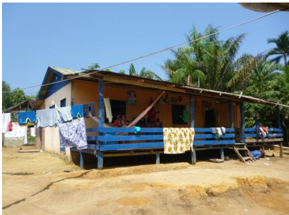
Figura 04: Casa de alvenaria Fonte: PIBIC/PIB-SA/0032/2011-2012
