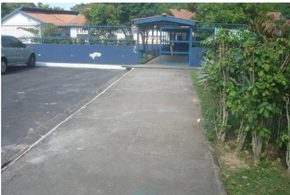
Figura 13 – Estrutura física de uma escola da zona Centro-Sul (Fonte: Vinente, 2012)
