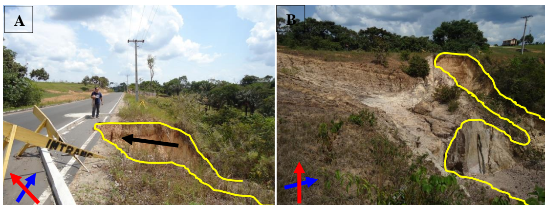
Figura 10: Voçoroca 4 no primeiro monitoramento. As setas em azul e vermelho indicam, respectivamente, a pista e o sentido do crescimento da incisão. Em A o contorno amarelo mostra que a incisão erosiva atingiu a pista, enquanto que em B o contorno em amarelo mostra a forma da incisão como bifurcada. Fotos. Deiziane, novembro/2012.
