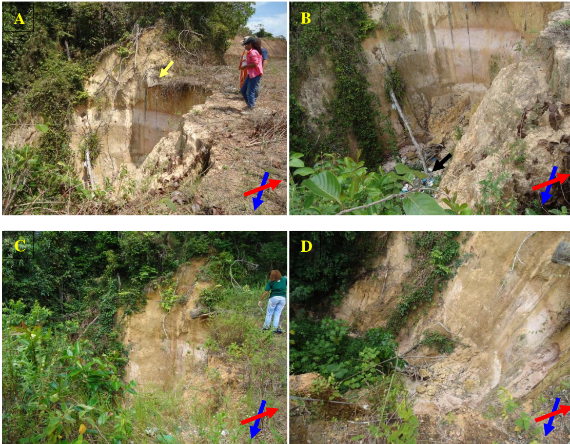
Figura 12: Voçoroca 5. Primeiro monitoramento: Em A seta em amarelo mostra a presença da canaleta. Em B podemos constatar a presença de lixo. Segundo monitoramento: Em C a vegetação se expande e em D o lixo foi soterrado pelos sedimentos provenientes da erosão. Fotos: Deiziane. Novembro/2013.
