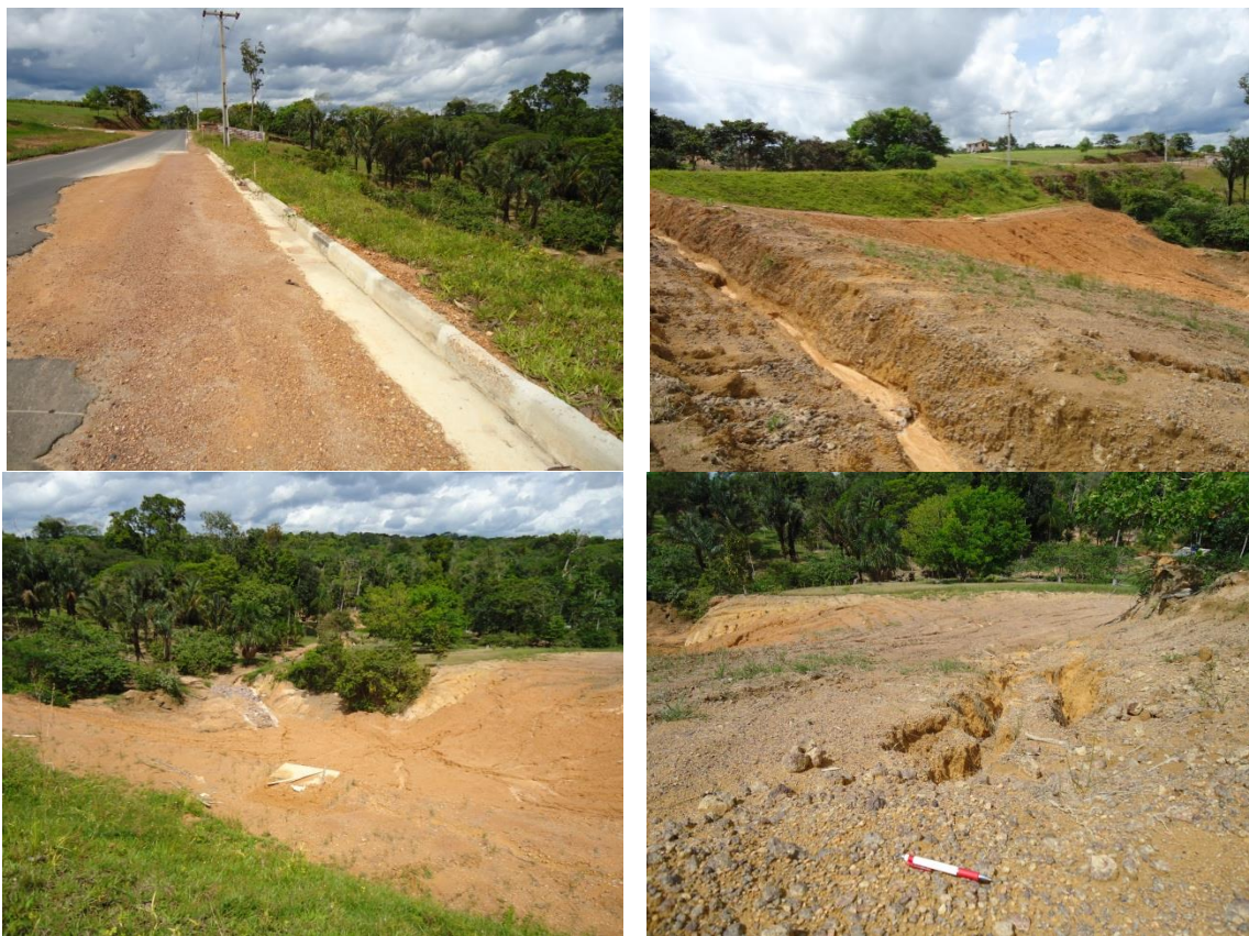
Figura 11: Após contenção da voçoroca 4 no segundo monitoramento. Fotos: Deiziane, julho/2013.
