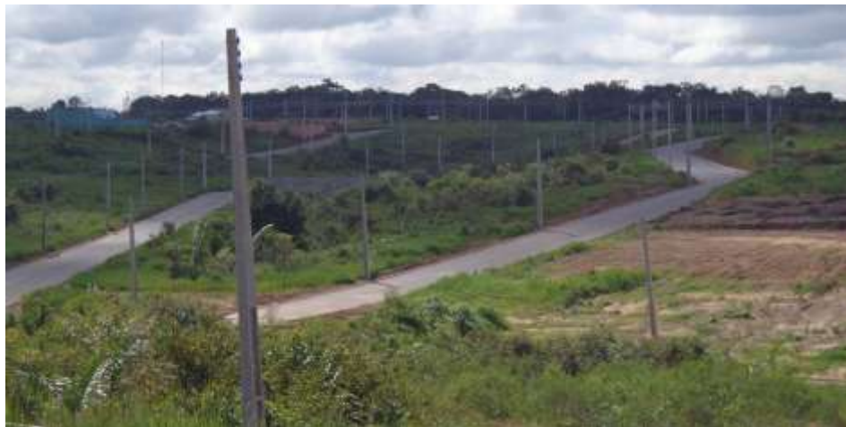
Figura 11 - Extensa área para a construção do Residencial Amazonas
