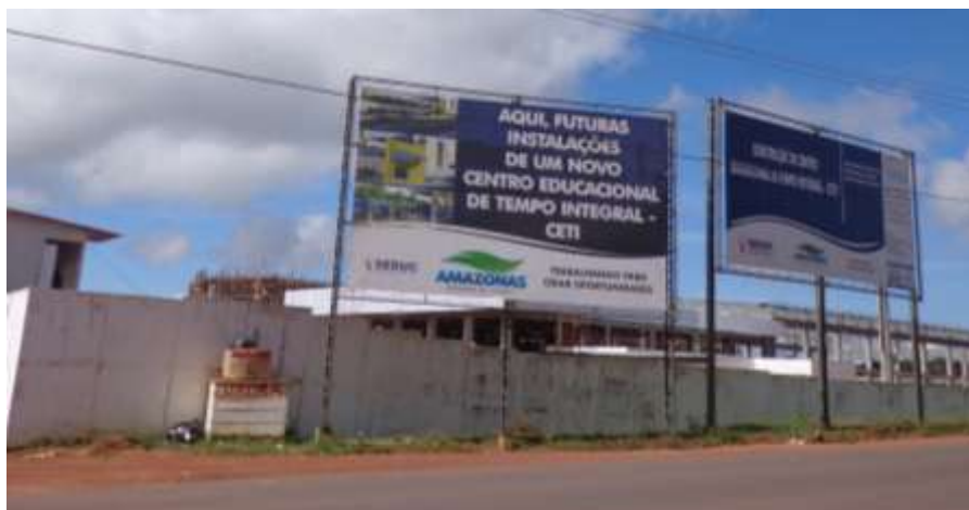
Figura 12 – Centro Educacional de Tempo Integral (CETI) em construção.
