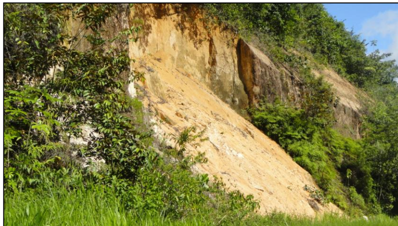
Fig. 11 – Movimento de massa, escorregamento translacional. BR-174 km 42. Fonte: Daniela P. Carvalho 17/01/2013
