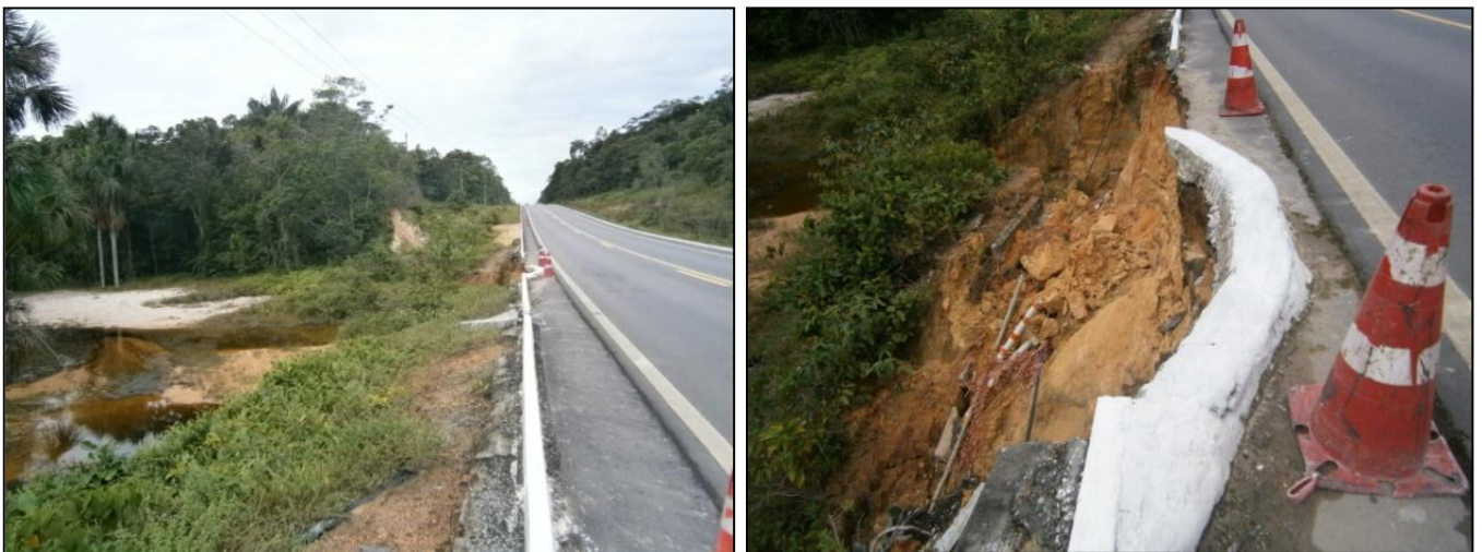
Fig.31 – Primeiro ponto de intervenção nas proximidades do km 36. Fonte: Letícia da S. Lima 13/06/2013.
