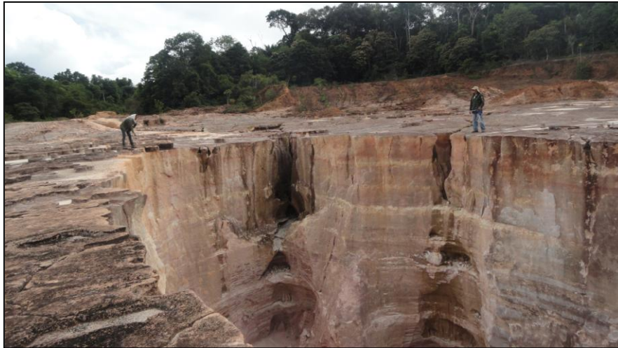
Fig. 12 – Monitoramento morfométrico da largura da voçoroca. BR-174 km 56. Fonte: Letícia da S. Lima 17/01/2013.
