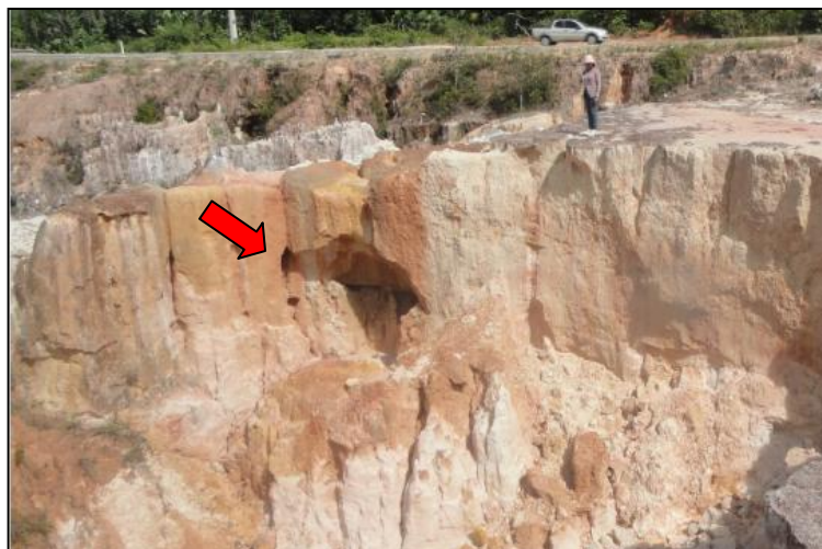
Fig. 09 – Marmiteira Residual (seta vermelha), voçoroca do tipo conectada, forma dendrítica. BR-174 km 45.
