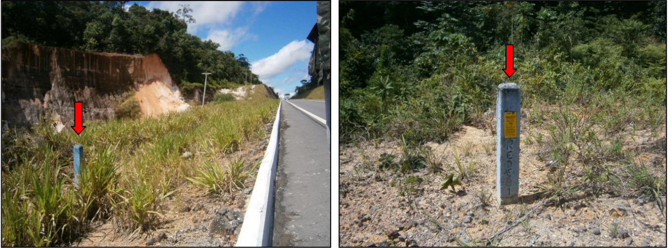
Fig. 34 – Rede cabo óptico enterrado (seta vermelha) km 52. Fonte: Letícia da Silva Lima 13/06/2013
