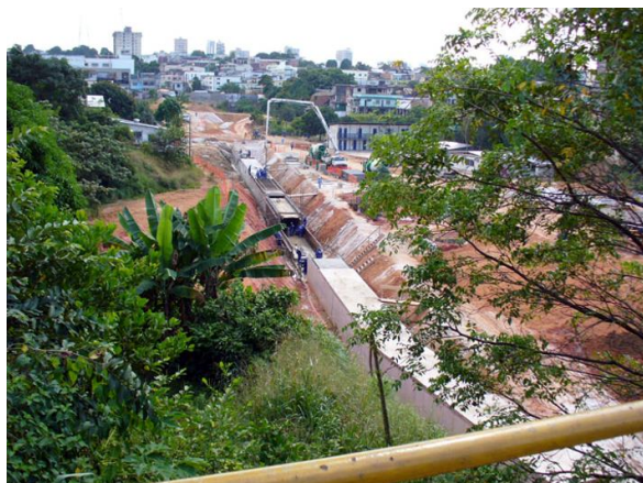
Figura 7: Macrodrainagem do Igarapé Manaus. Fonte: Unidade de Gerenciamento do PROSAMIM – UGPI
