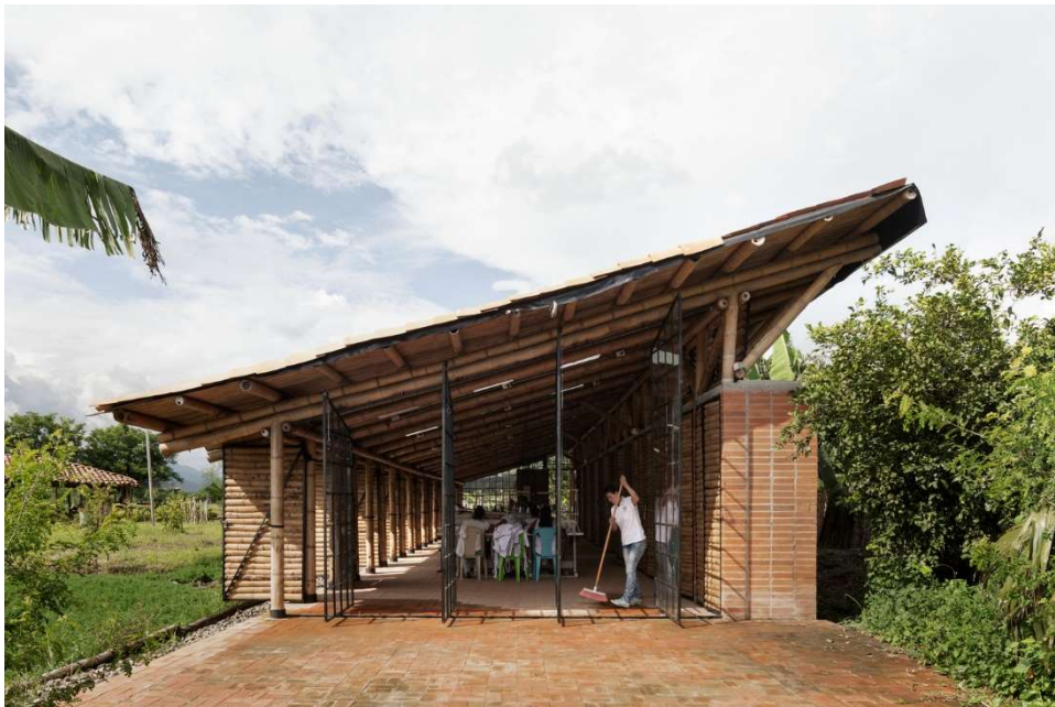
Figura 10: Vista Lateral da edificação - Fonte: Federico Caioli
