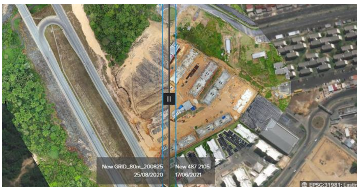
Figura 30 — Acompanhamento da Obra: Caso 1 - agosto/2020 e junho/2021
