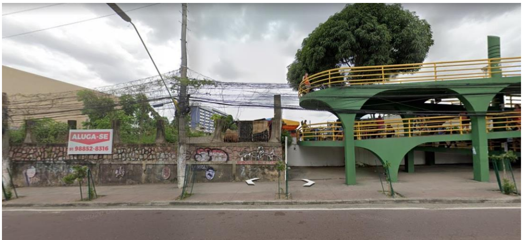
Imagem 29: Fachada oeste do lote, a partir da Av. Djalma Batista. Fonte: Google Street View, 2021
