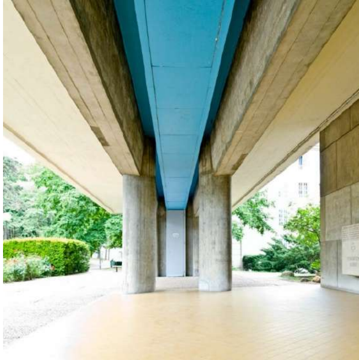
Figura 21 – Estrutura do Pavilhão Suíço, em Paris, França.
