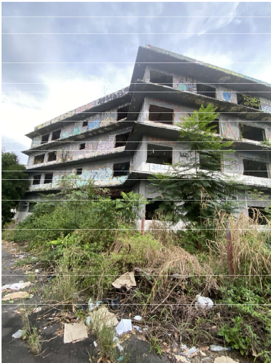
Figura 53– Fachada atual do antigo prédio da ISAE.
