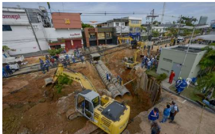
Figura 47 – Obra de troca de drenagem profunda do igarapé do Mindú.
