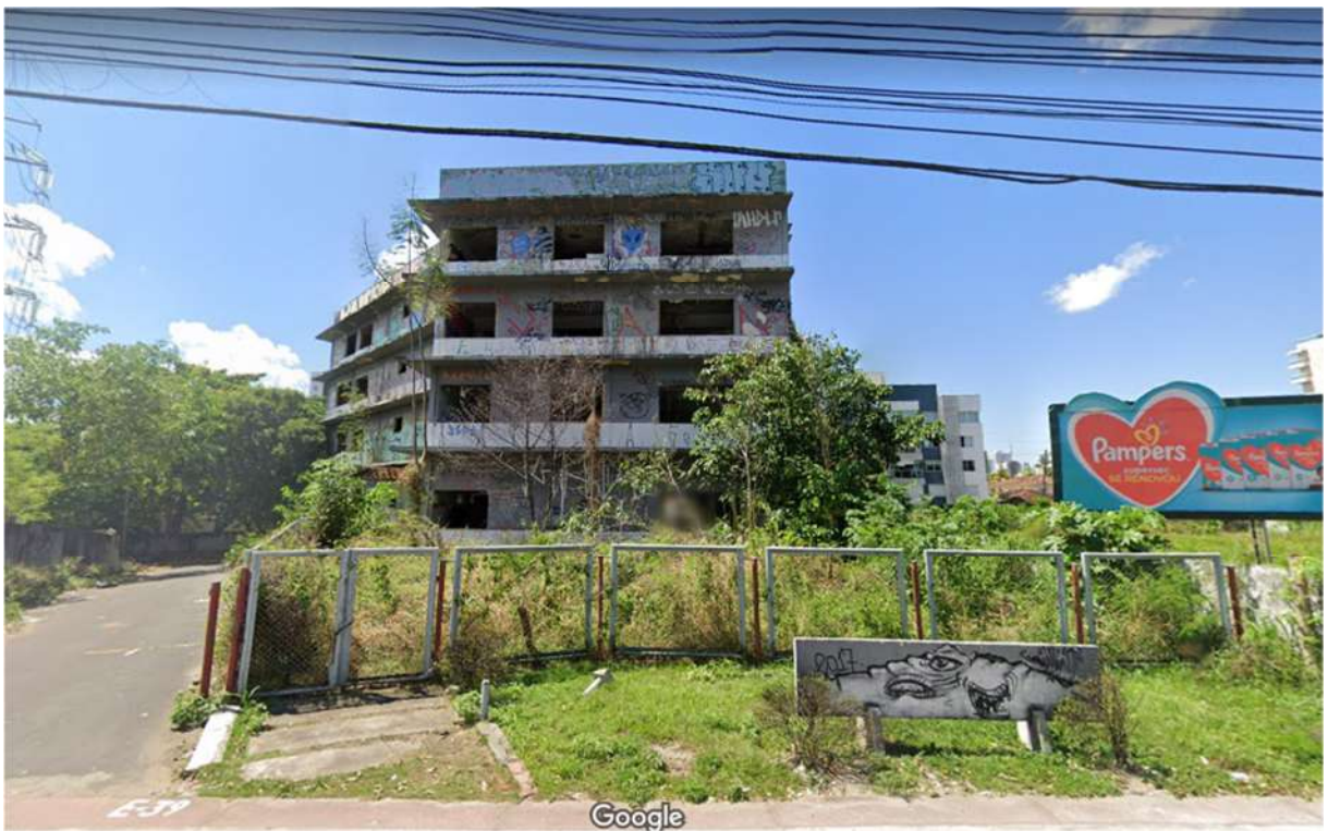
Figura 52– Fachada atual do antigo prédio da ISAE.
