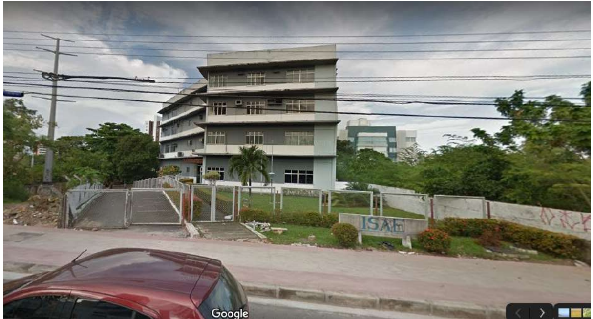
Figura 51 – Fachada do antigo prédio da ISAE.
