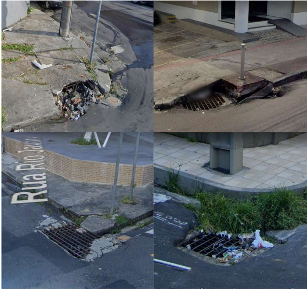
Figura 75 – Bocas de lobo.
