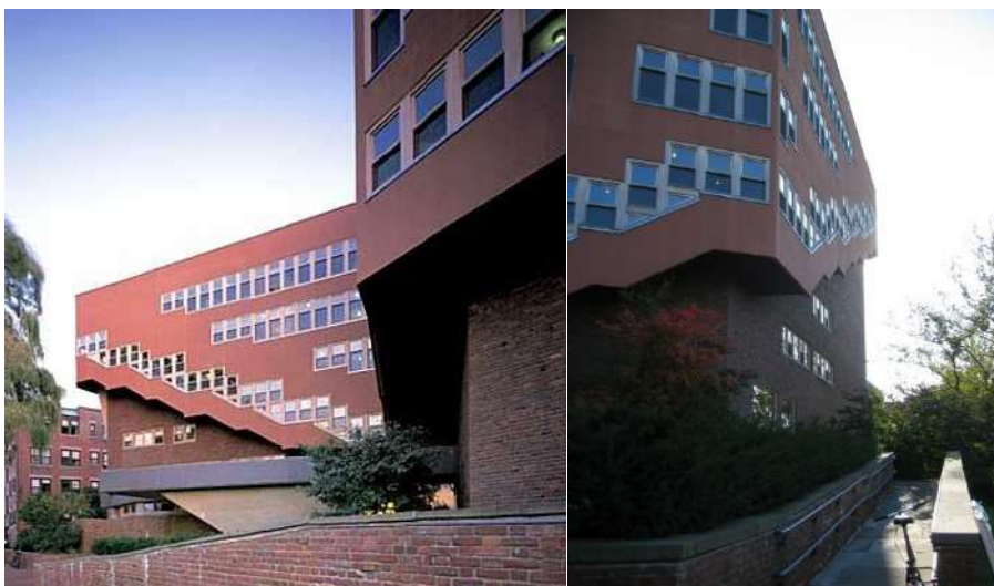
Figura 30 – Fechamento e composição das escadas na fachada do Dormitório MIT – Baker House, Cambridge, MA, EUA..
