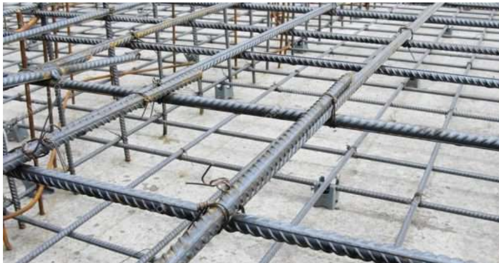
Figura 99 – Armadura em aço para sistema estrutural de concreto.
