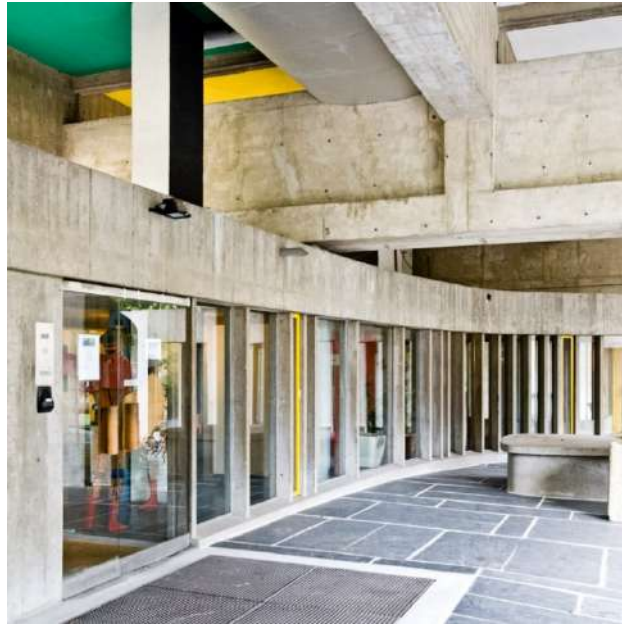
Figura 32 – Vista da estrutura da Casa do Brasil, em Paris, França.
