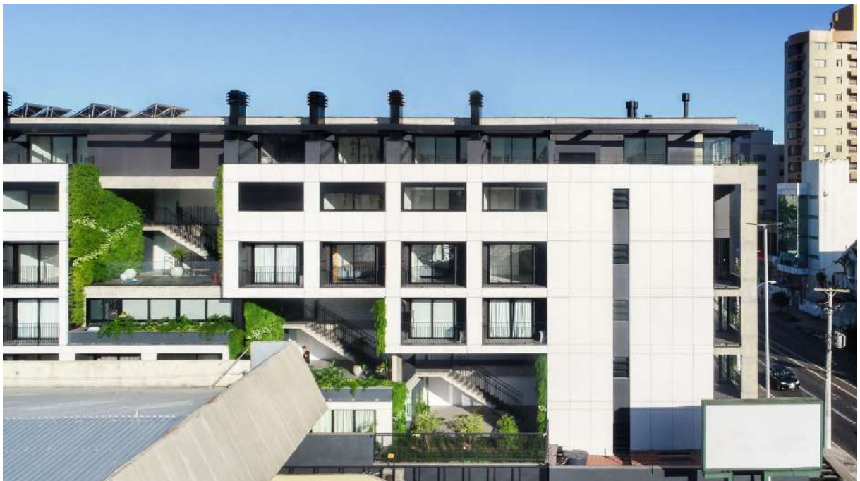
Figura 44 – Vista Fachada Lateral. Praça 4. Porto Alegre, Rio Grande do Sul. Fonte: Archdaily.
