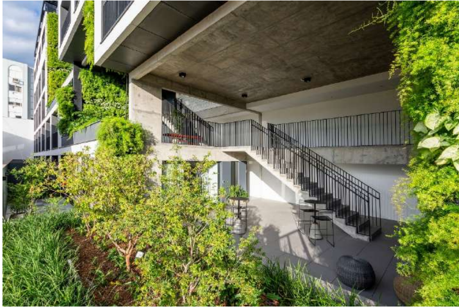
Figura 43 – Vista Praça Interna. Praça 4. Porto Alegre, Rio Grande do Sul. Fonte: Archdaily.
