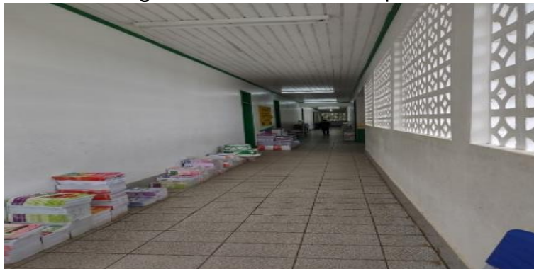
Figura 34- Corredor do 2º piso
