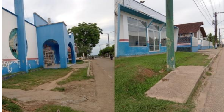
Figura 19- Trecho da av. Castelo branco e rua Frei Ludovico
