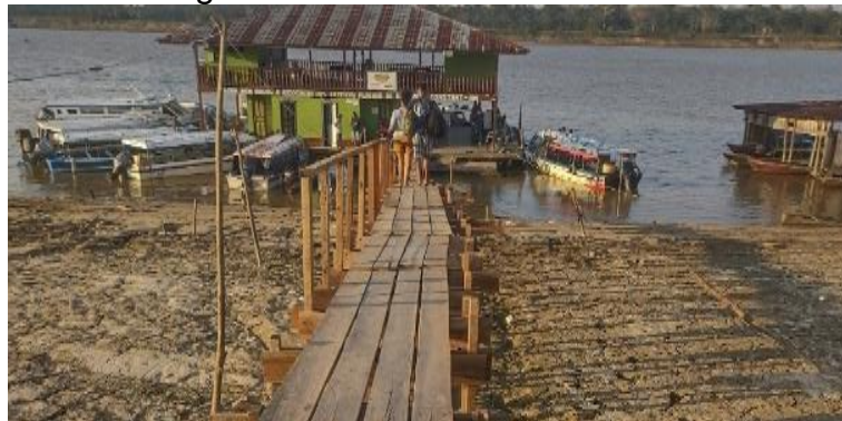
Figura 03- Passarela de madeira
