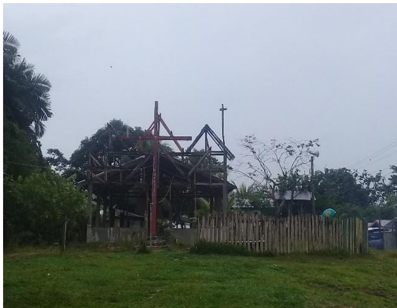
Figura 2. Construção da igreja atual. Fonte: Tatiana Samias 2021
