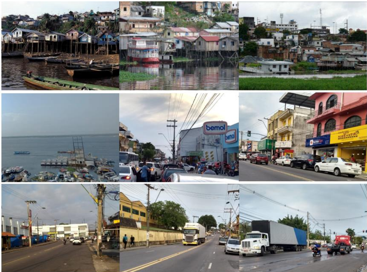
Imagem 53: Áreas alagáveis de habitação (acima), regiões de serviço e comércio (ao meio e abaixo). Fonte: Elaborado pela autora.
