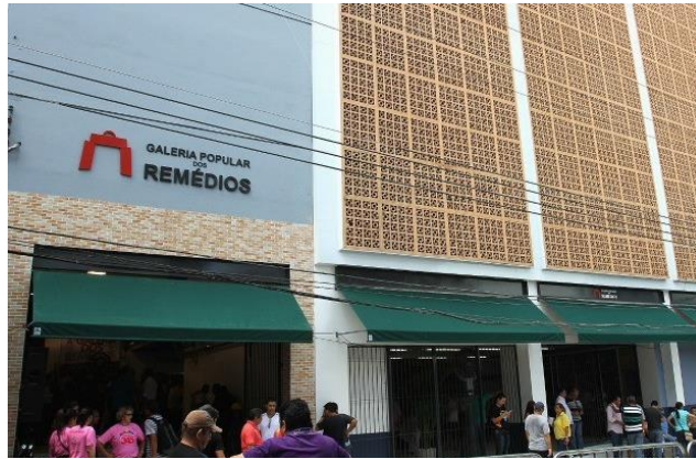
Figura 13: Galeria dos Remédios
