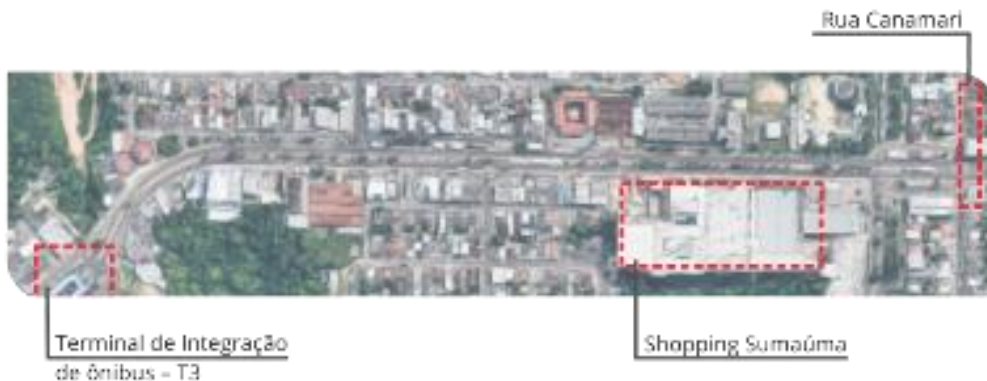
Figura 26: Trecho de diagnóstico – Avenida Noel Nutels Fonte: Autora
