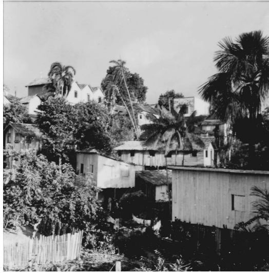
Figura 22 – Palafitas de madeira próxima a avenida Silves, Manaus
