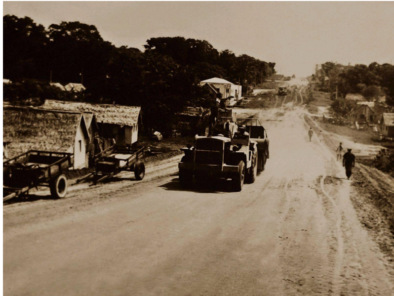
Figura 19 - Construção da Avenida Silves, via importante do bairro Raiz
