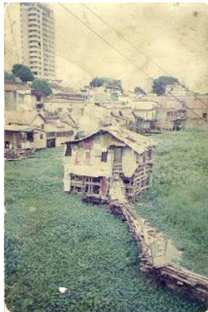
Figura 14 – Casebre no centro de Manaus, avenida 7 de setembro, anos 90.
