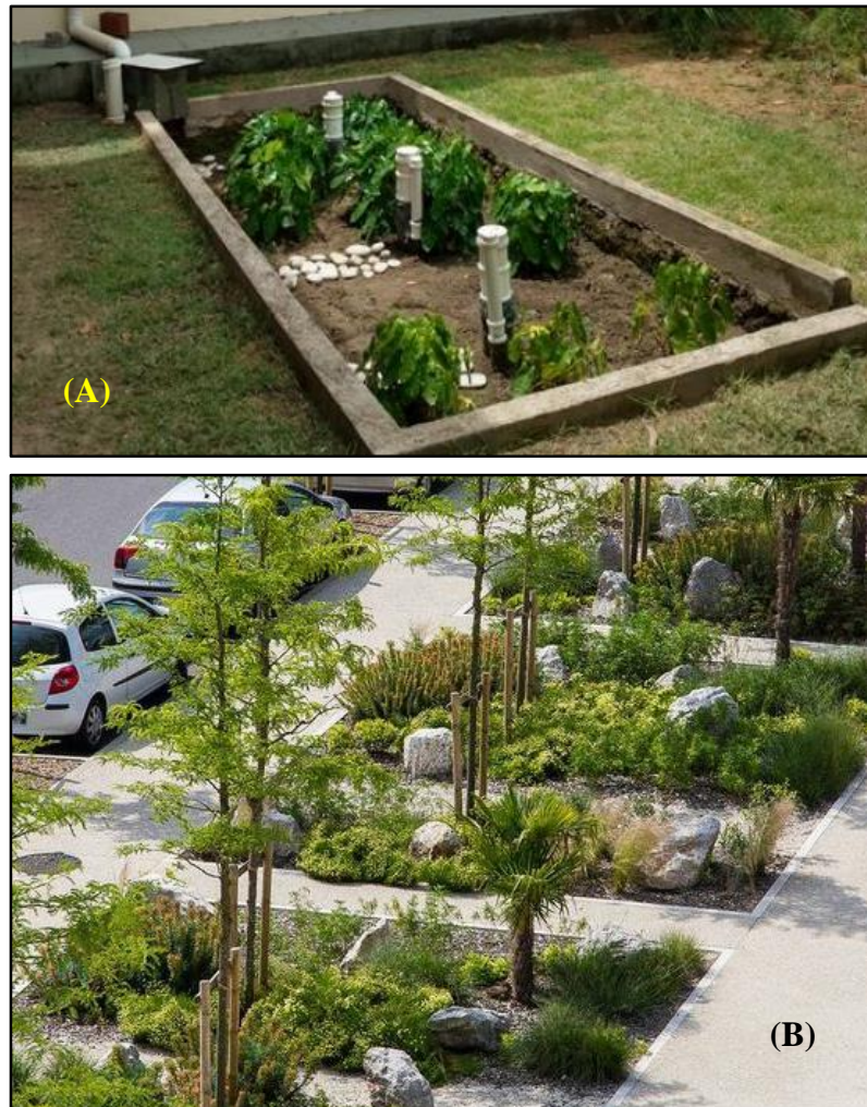
Figura 12: sistemas de biorretenção (A) Jardins de chuva (B) Canteiros Pluviais
