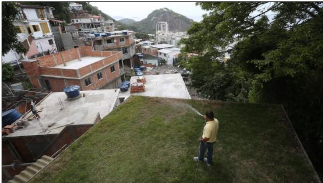
Figura 37: Telhado verde aplicado em edificação na comunidade
