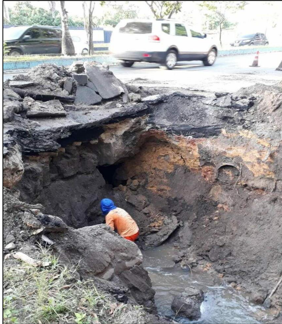
Figura 33: Pista cedida decorrente da rede de drenagem profunda existente
