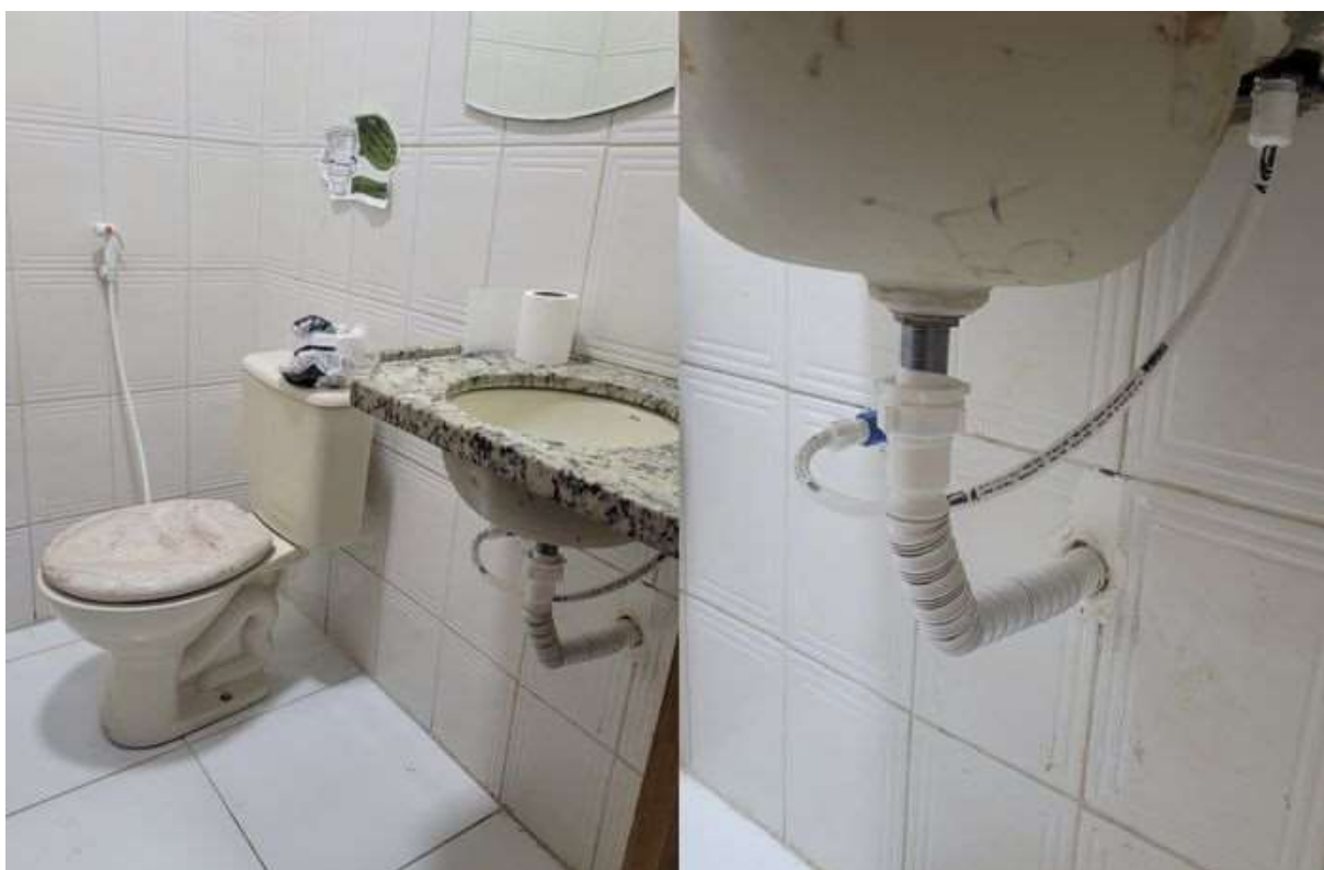
Figura 31 — Banheiro feminino sala 2
