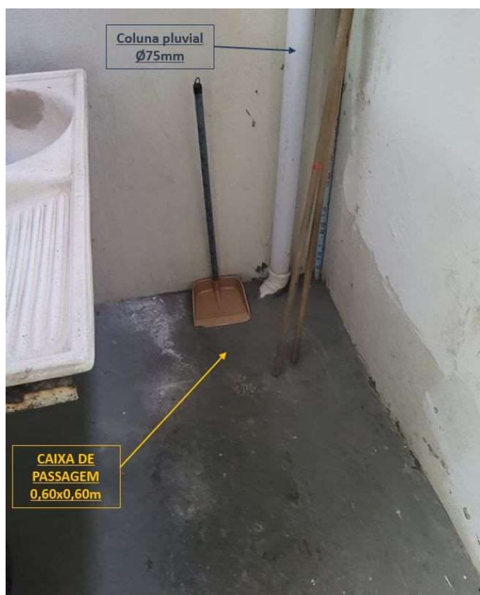
Figura 50 — Caixa de passagem poço de ventilação
