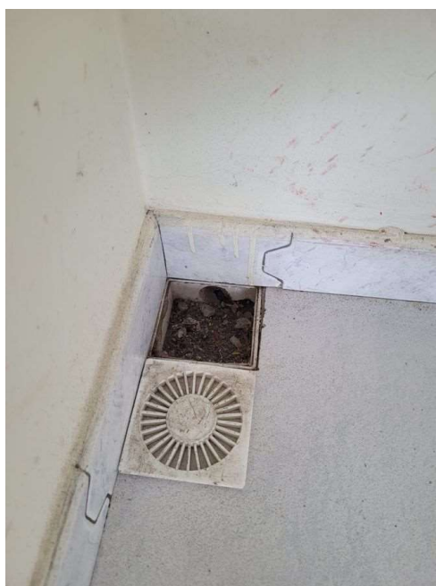
Figura 26 — Ralo seco localizado no refeitório
