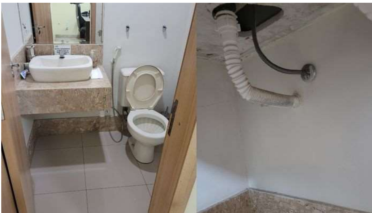
Figura 36 — Sifão sanfonado do banheiro da diretoria
