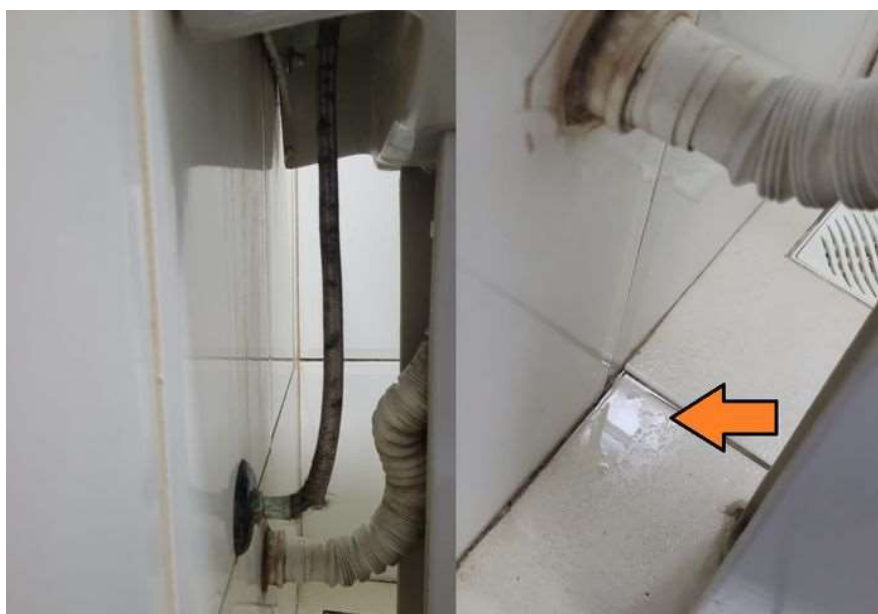
Figura 44 — Sifão sanfonado banheiro do Almoxarifado
