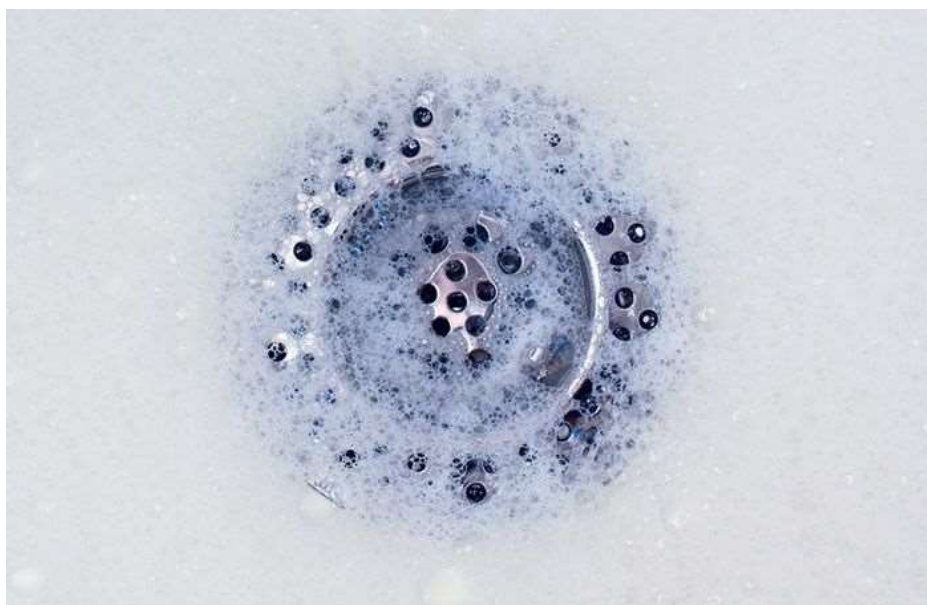
Figura 8 — Retorno de espuma pelo ralo
