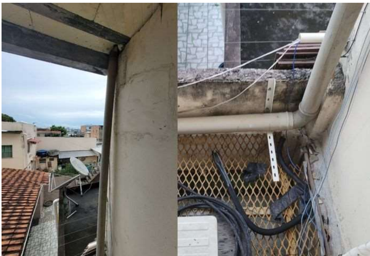
Figura 47 — Tubo de queda de gordura
