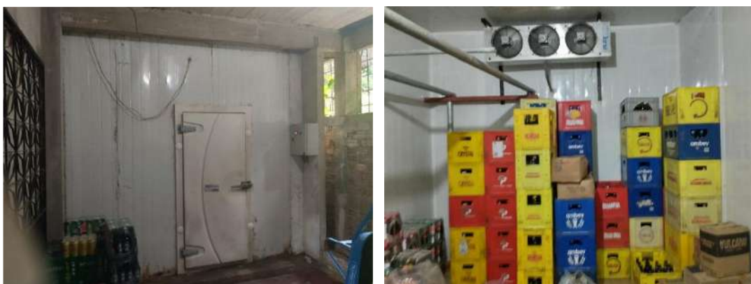
Figura 13. Visão Externa e Interna do Frigorífica da Empresa V. S. Garcia.
