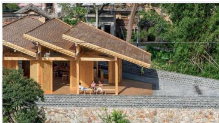
Figura 9 – Módulos de cobertura que permitem a permeabilidade de luz.
