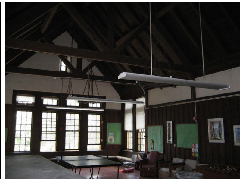
Figura 16: Antigo ginásio (anterior à intervenção) Fonte: DaSilva Architects (2016)
