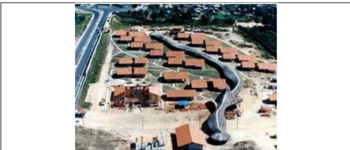
Figura 7-Vista aérea da Aldeia SOS do Amazonas, em fase final de construção Fonte:arquivo pessoal de Severiano Porto em ROVO
