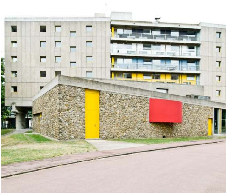
Figura 9 - Fachada da Casa do Brasil, Paris, França Fonte: Archdaily, 2017
