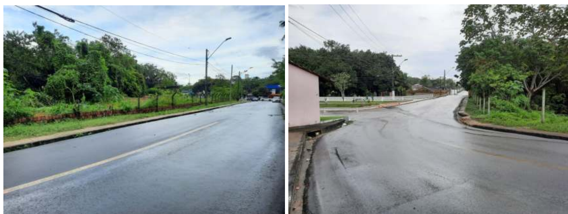
Figura 34 - Rua "A" Fonte: Autoria própria, 2022.
