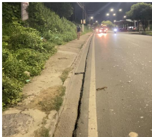
Figura 47: Indivíduo praticando cominhada na Av. Noel Nutels, em calçada sem infraestrutura – Fonte: compilação autor
