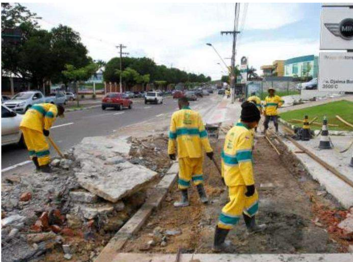
Figura 10 — Obra de Calçada em Manaus
