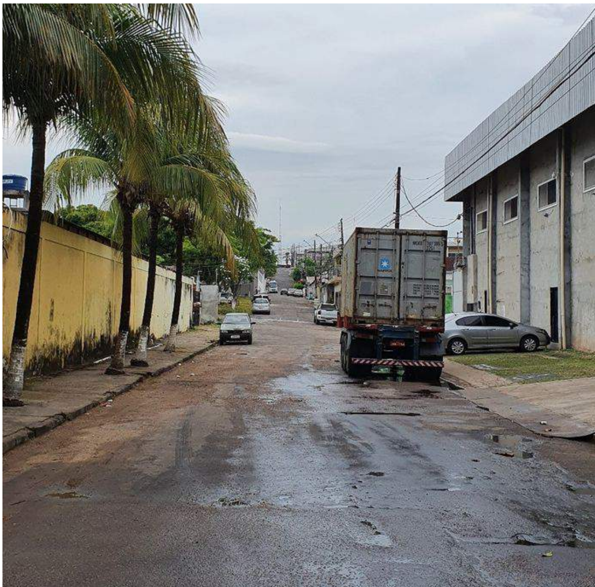
Figura 15 — Rua B, via local. Estado de conservação da pista
