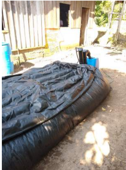
Figura 24 – Local escolhido para instalação do Biodigestor.
