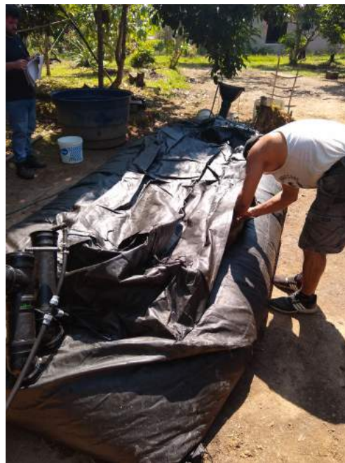
Figura 25 – Instalação do conjunto da pia e saída de gás.
